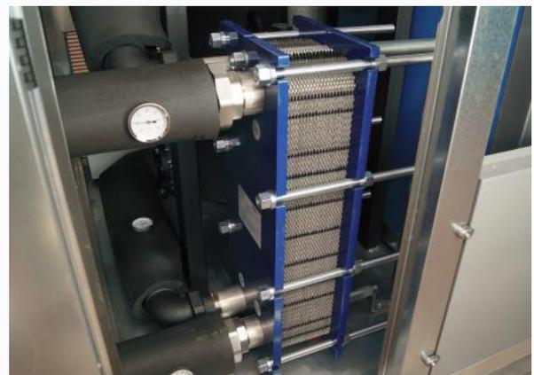
► Equipo ROOF TOP con intercambiador de placas.
